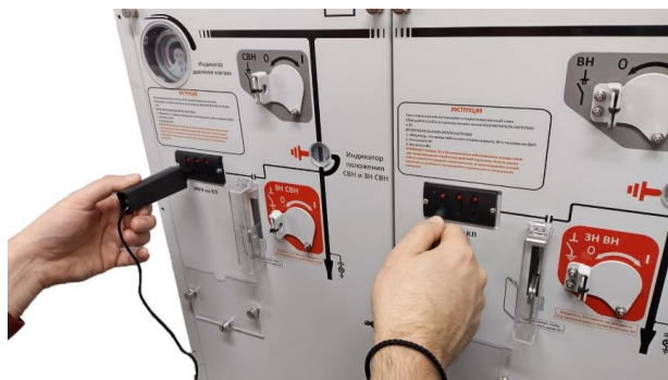
Рис. 8.3 Проведение фазировки
